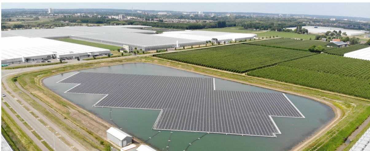
Drijvend zonnepanelen op een gietwaterbassin in kassengebied Next Garden, Huissen. Hier speelt ecologie geen rol. (Foto: Lingewaard Energie)
