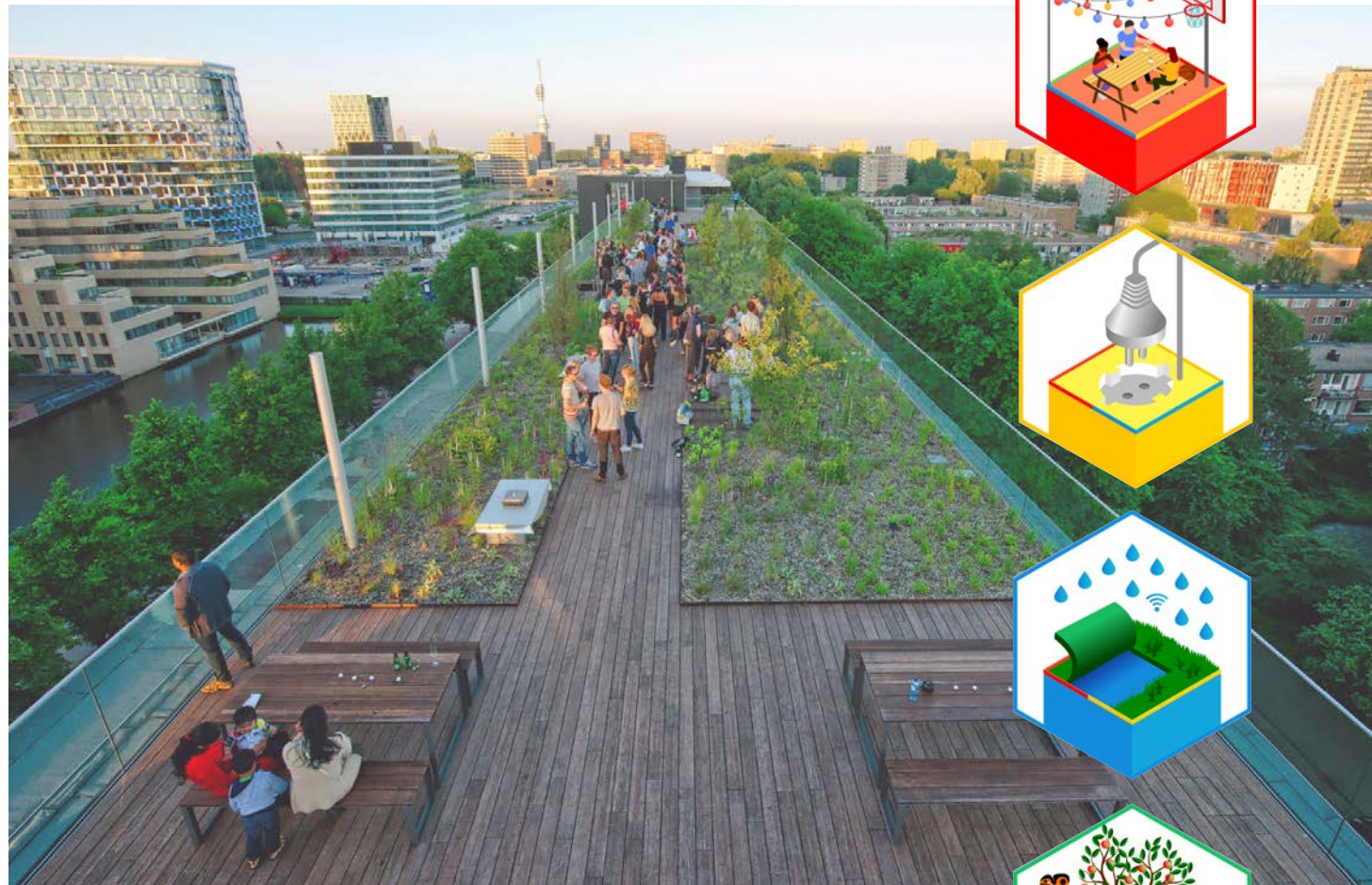
Gebouw De Boel aan de Boelelaan in Amsterdam. Daktuin voor huurders van het gebouw, gebouwd op een polderdak.
