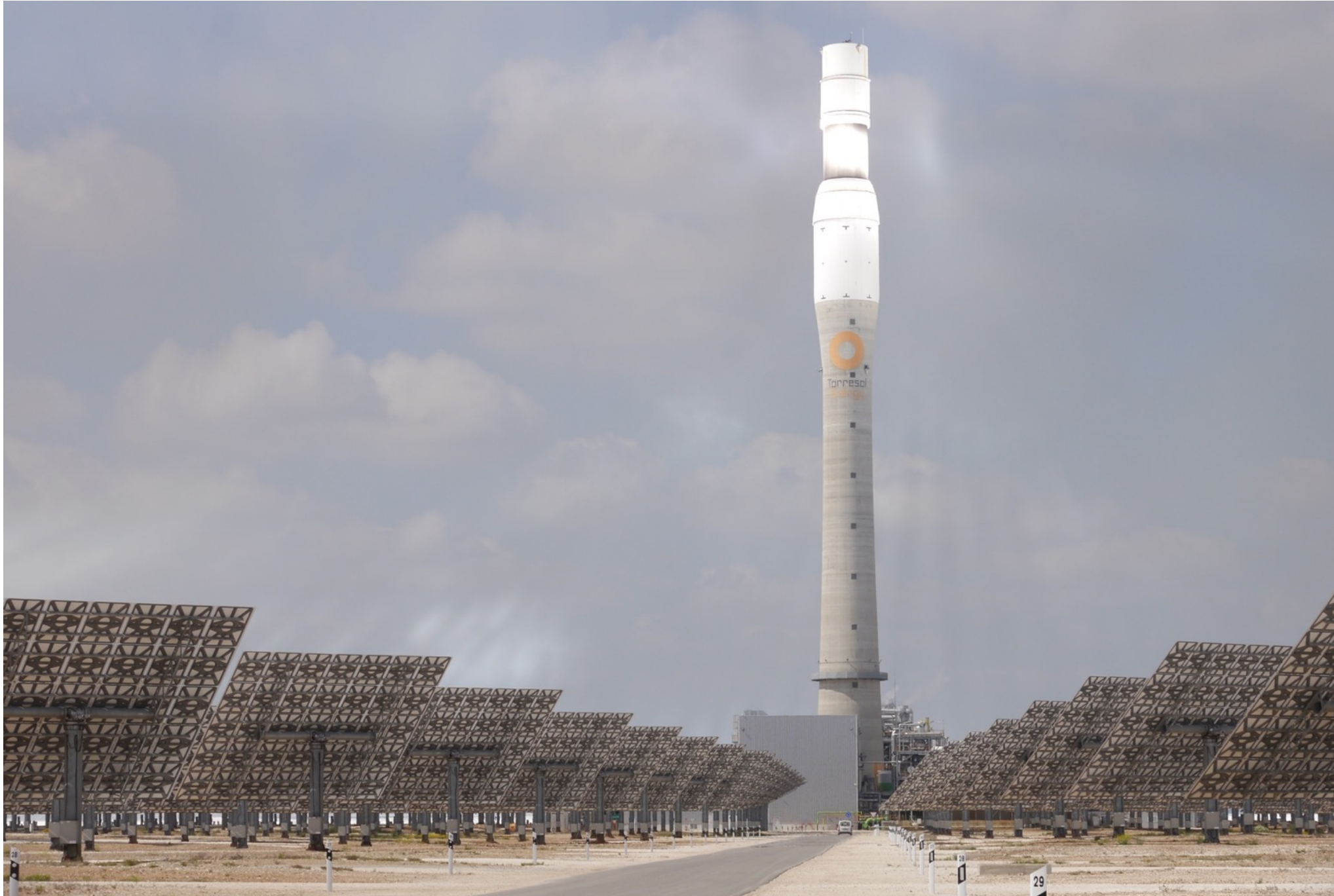
CSP Gemasolar (Spanje) 20 MW (foto: Dirk Oudes)
