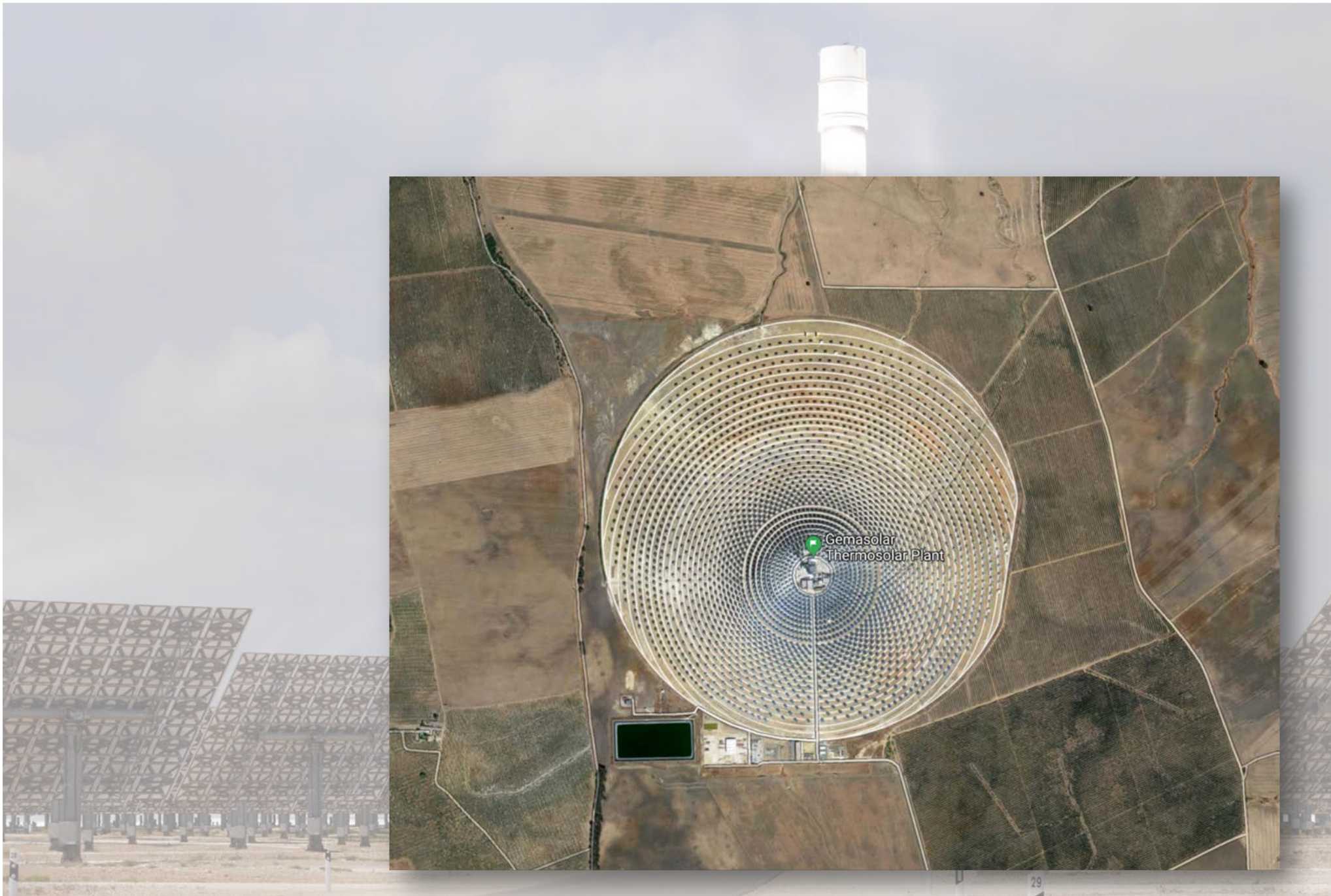
CSP Gemasolar (Spanje) 20 MW (foto: Dirk Oudes)
